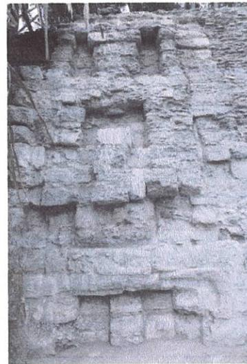
Además en la fachada oeste se trabajó en el desenraizado y la eliminación de un tronco de un árbol de la especie conocida como ramón y en la recuperación de volumen perdido en el núcleo de ña pirámide, se trabajó una superficie de 30 m<sup>2</sup> del talud en el penúltimo cuerpo de la esquina noroeste.
