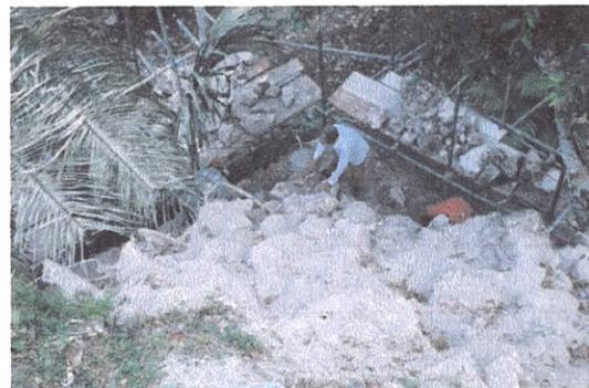
4. En el edificio B-18 en el sitio arqueológico Naranjo, se trabajó en la estabilización de 40 m<sup>2</sup> de gradas y dos cuerpos en la fachada este del edificio, para ello fue necesario resanar sisas, desmontar sillares originales, se estabilizó el núcleo y se colocaron nuevamente los sillares originales utilizando mezcla hecha a base de cal como aglutinante.
